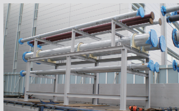
配管ユニット
