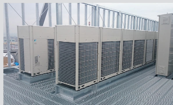
室外機ユニット
