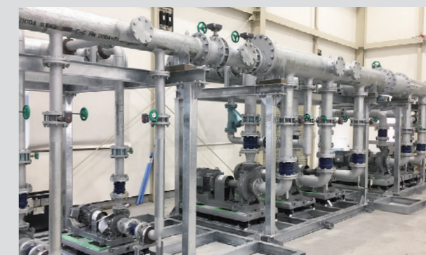
ポンプユニット
